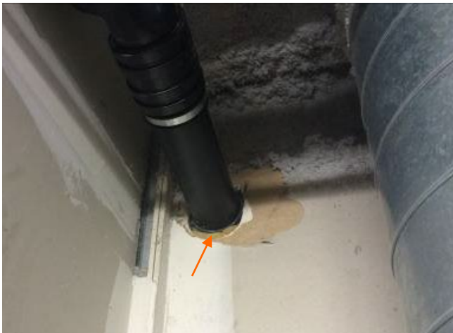
Incorrect : longueur manchon insuffisante
